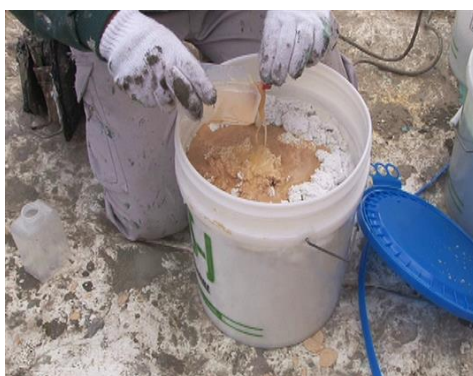
仕上1缶にカラー1本を入れる ボトルにカラーが残らな様に出し切る
